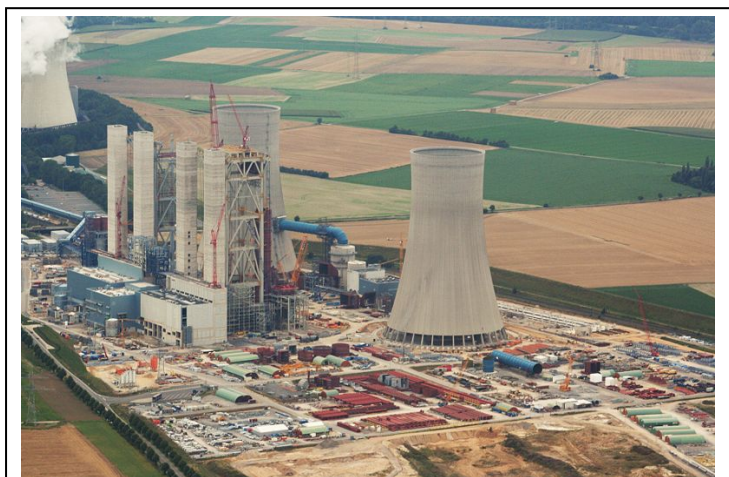
Bild 6: Kraftwerksbaustelle BoA 2/3 Neurath [23]
