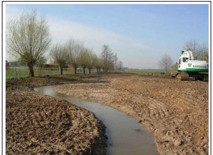
Bild 4: Umbau der Niers bei Wanlo
