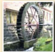
Das Wasserrad der Holzmühle, gelegen im Tal des Mühlenbachs, trieb ursprünglich ein Holzsägewerk an. Daher stammt auch das Wort „Holt“. Heute zählt das eiserne Rad mit fast 6 Metern Durchmesser zu den größten im Schwalmgebiet. Die idyllische Lage am großen Mühlenwehler lädt viele Wanderer und Radfahrer zum Verweilen ein.
